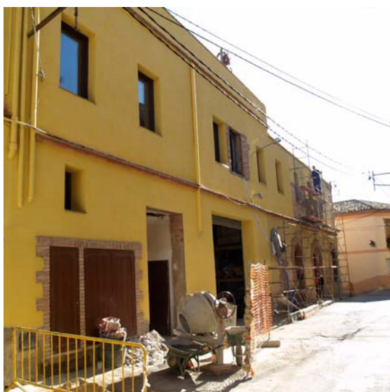
Fachada de la antigua cooperativa, actualmente en obras.
