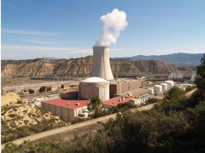
Vista de la Unitat II de CN Ascó.
