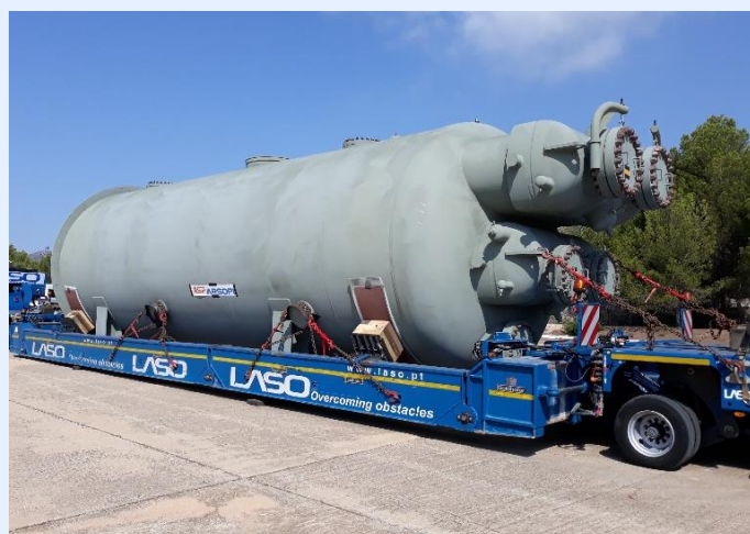
Traslado y trabajos de preparación de los MSR para su instalación en CN Vandellós II.
