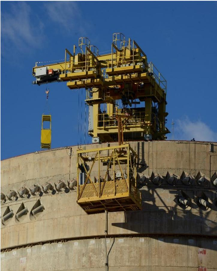
Trabajos de postensado del hormigón del edificio de contención.
