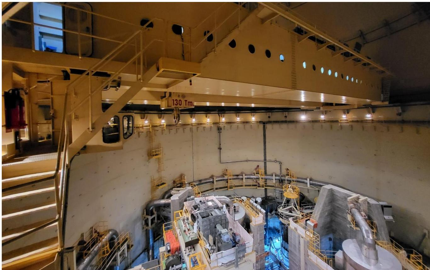
Trabajos de sustitución de los equipos de regulación y control de la grúa polar del edificio de contención.
