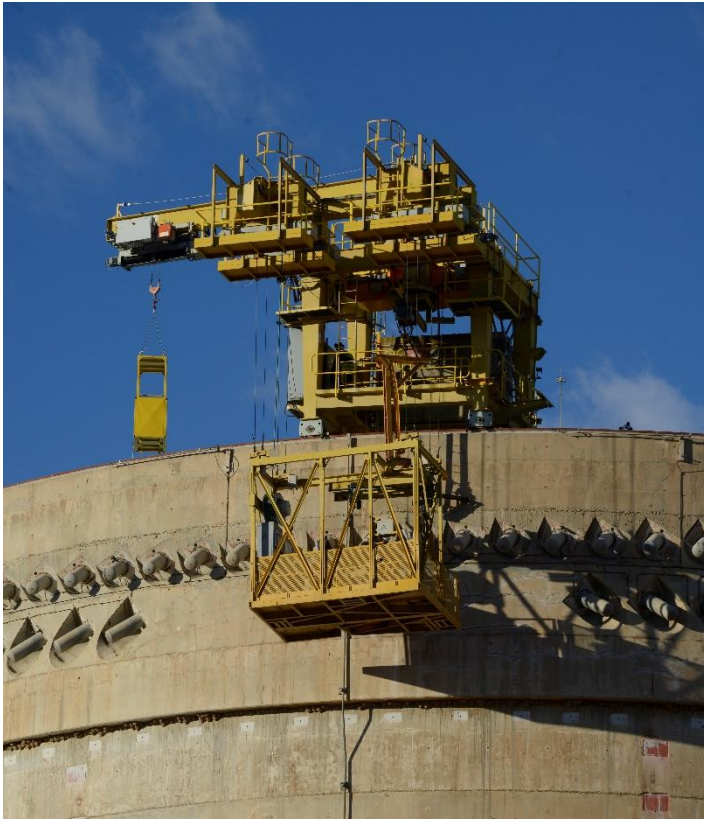
Traballs de post-tensat del formigó de l'edifici de contenció.
